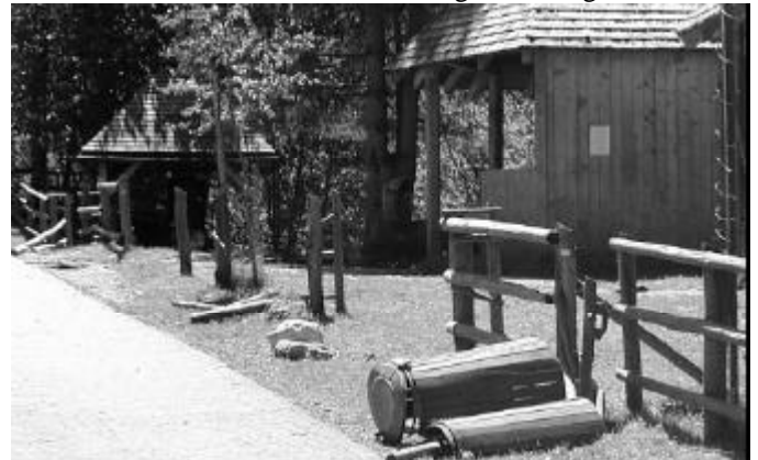
Weniger erfreulich II: Die Grillhäuschen in den „Stocker“-Wiesen waren Ziel einer mutwilligen Zerstörungsaktion - das Gute daran: Die Akteure waren zur Wiedergutmachung bereit.
