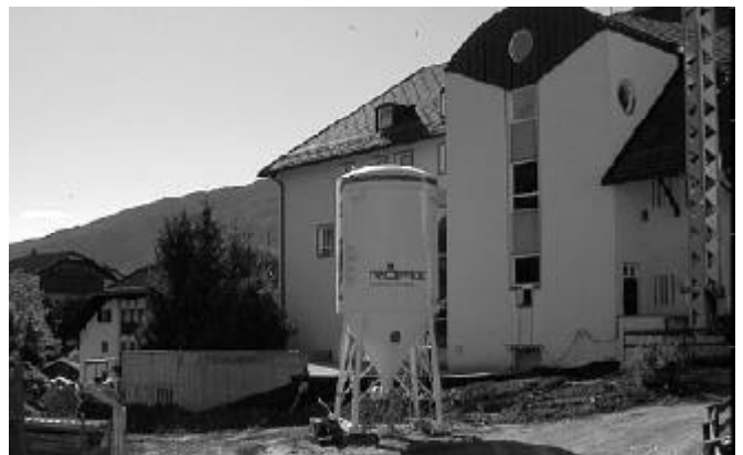
Der Bau des Probelokals für die Pfarrmusik wurde begonnen
